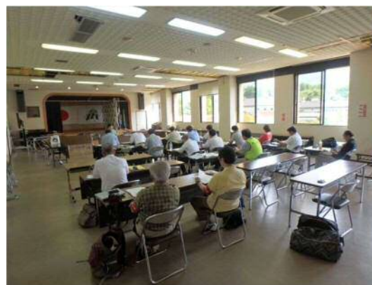
南阿蘇村役場でのヒアリング (天井板が落ちている)
